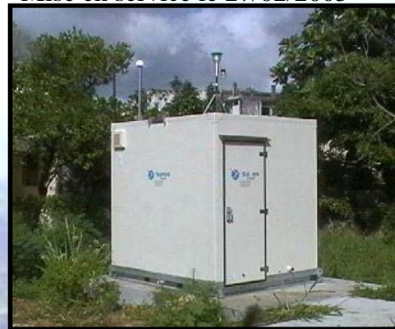
Station « Lamentin » Quartier Four à Chaux, Mise en service le 02/04/2003
