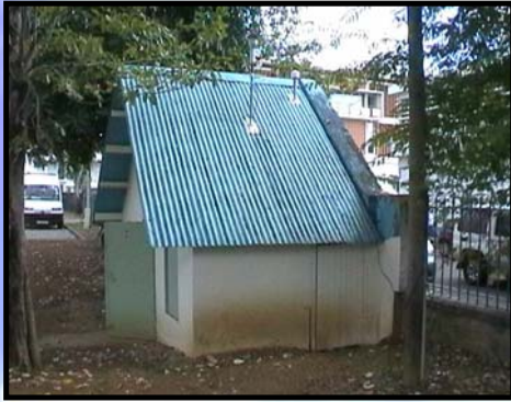
Station « Musée d'Histoire » Centre de Fort-de-France, Mise en service le 24/10/2000
