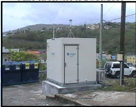
Station « Schoelcher » Les hauts du Bourg, Mise en service le 01/04/2003
