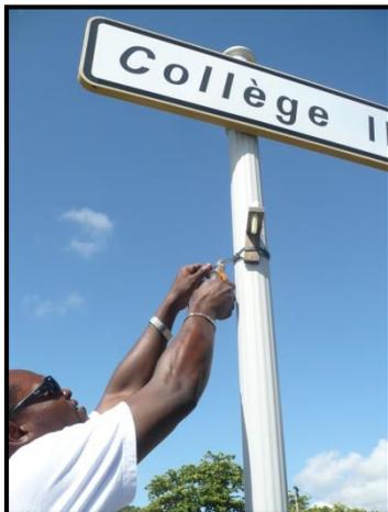
Les tubes sont posés à environ 2 mètres du sol, essentiellement pour des raisons de vandalisme, sur des supports (lampadaire, poteau...) et restant représentative de l'air respirable. Les tubes sont posés sur des supports en bois qui sont fixés au poteau à l'aide de collier de serrage.
